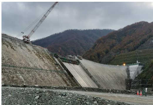
100m 超の堤体を見上げる
